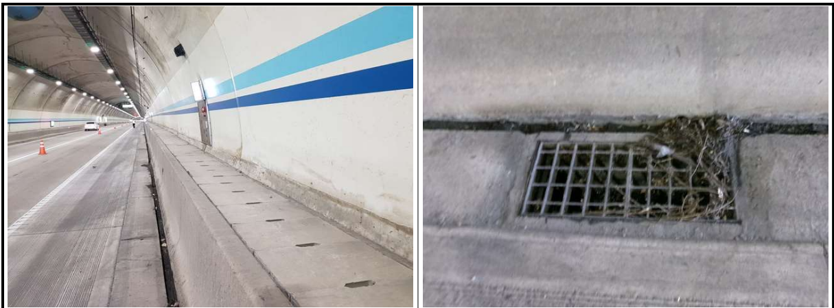
【사진 1.3.21】 공동구 및 배수시설 전경
