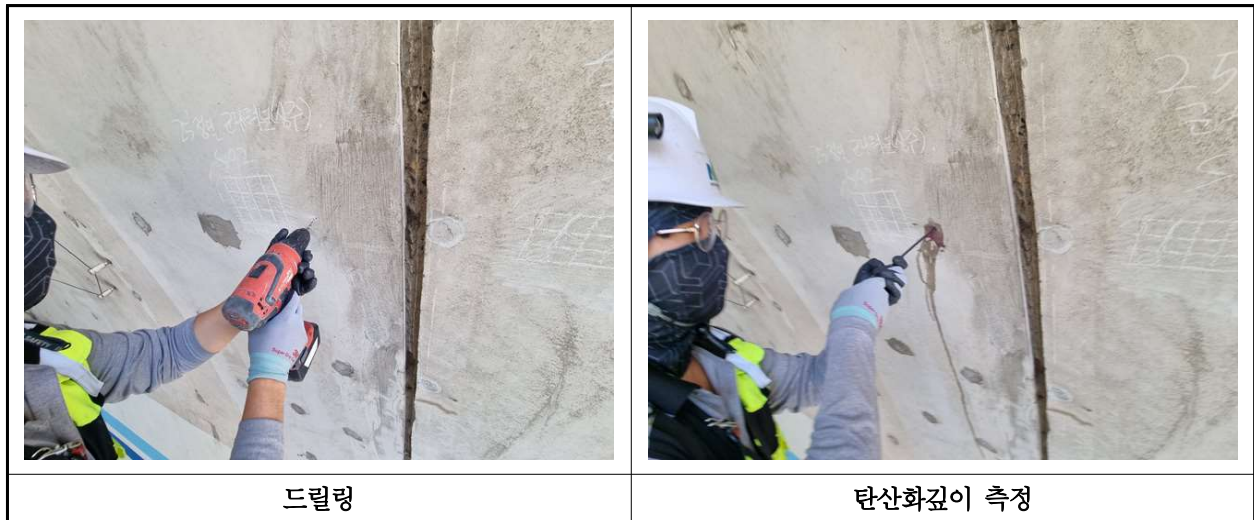
【사진 1.4.3】 탄산화 깊이 측정 현장사진
