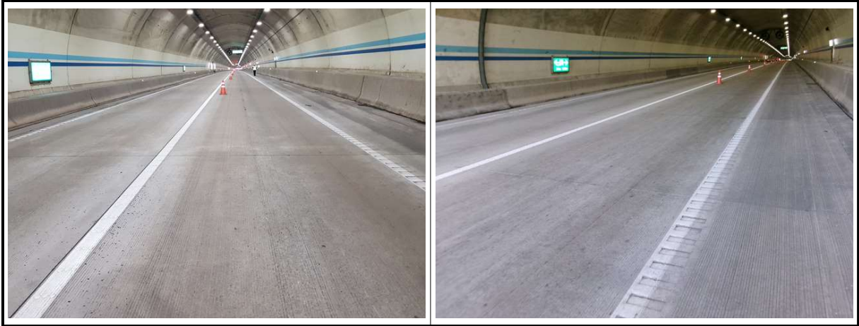
【사진 1.3.23】 포장부 전경
