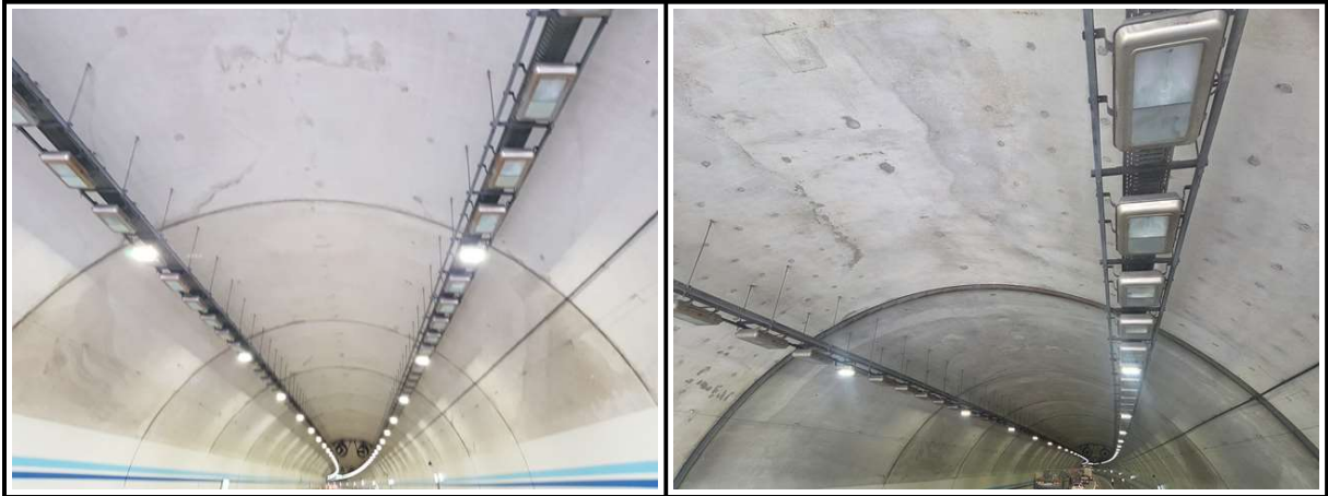
【사진 1.3.1】 라이닝 천단부 전경
