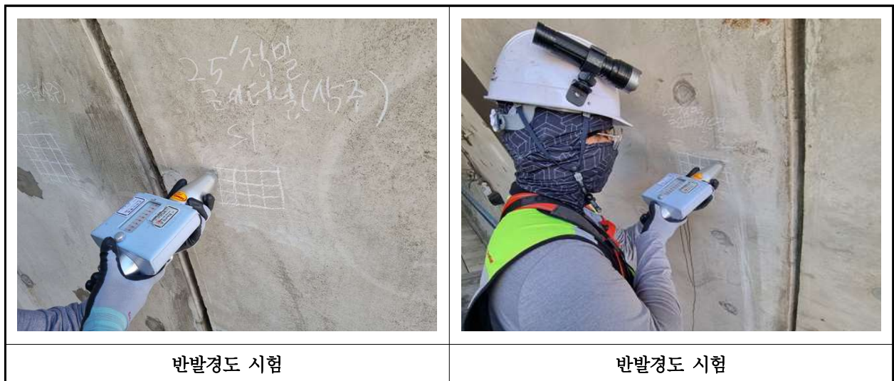
【사진 1.4.2】 반발경도시험 현장사진
