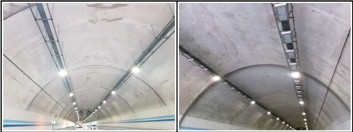
【사진 1.3.14】 라이닝 천단부 전경
