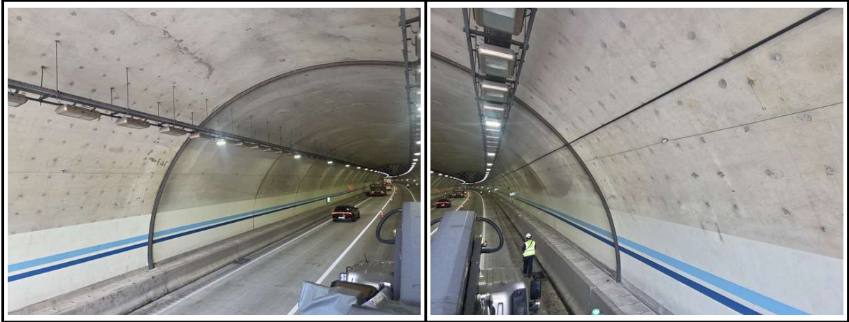
【사진 1.3.3】 라이닝 측벽부 전경
