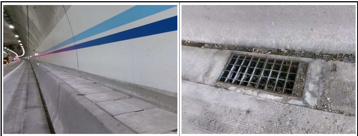
【사진 1.3.8】 공동구 및 배수시설 전경
