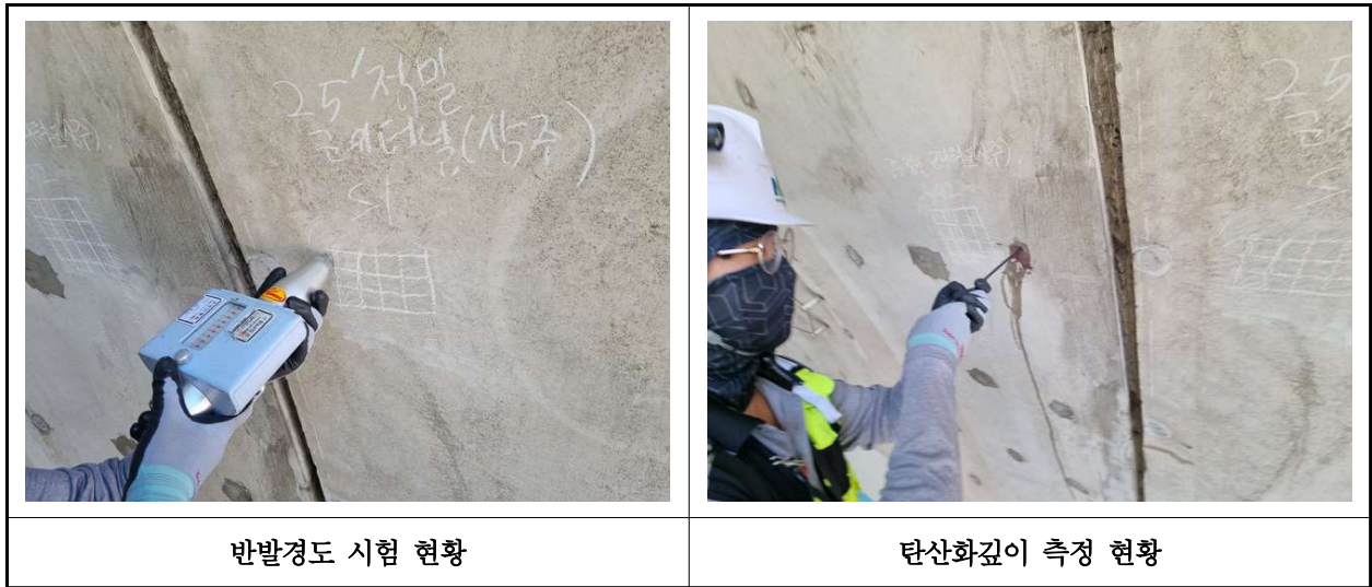
【사진 1.4.1】 콘크리트 내구성조사 현황
