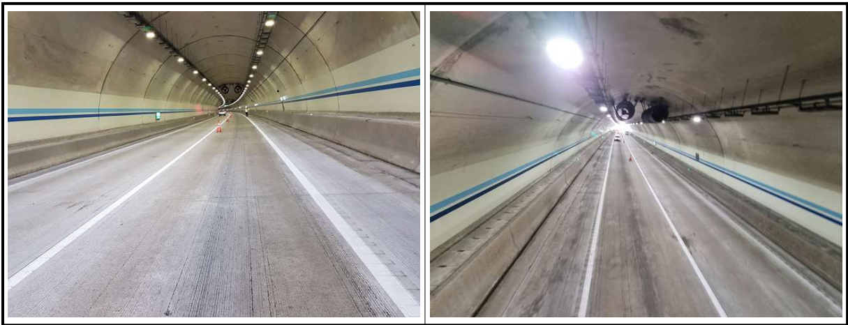
【사진 1.3.10】 포장부 전경
