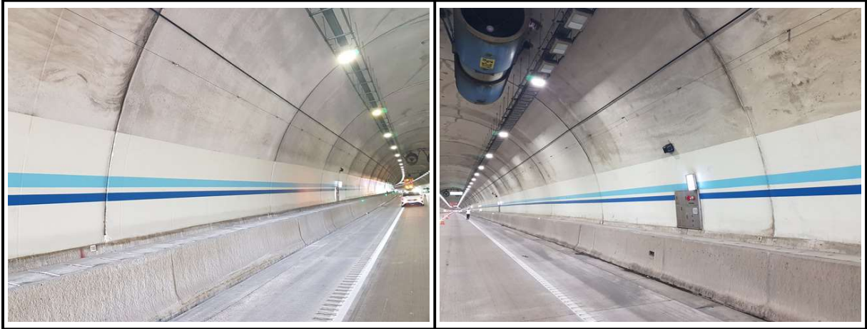
【사진 1.3.16】 라이닝 측벽부 전경
